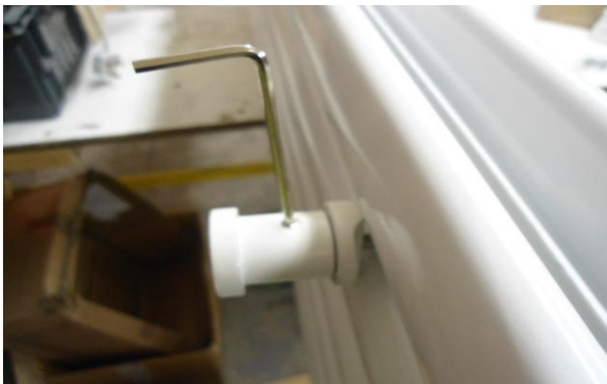
Simplemente aflojar la varilla roscada en el posterior del soporte ( con la llave hexagonal incluida) para fijar a la pared
