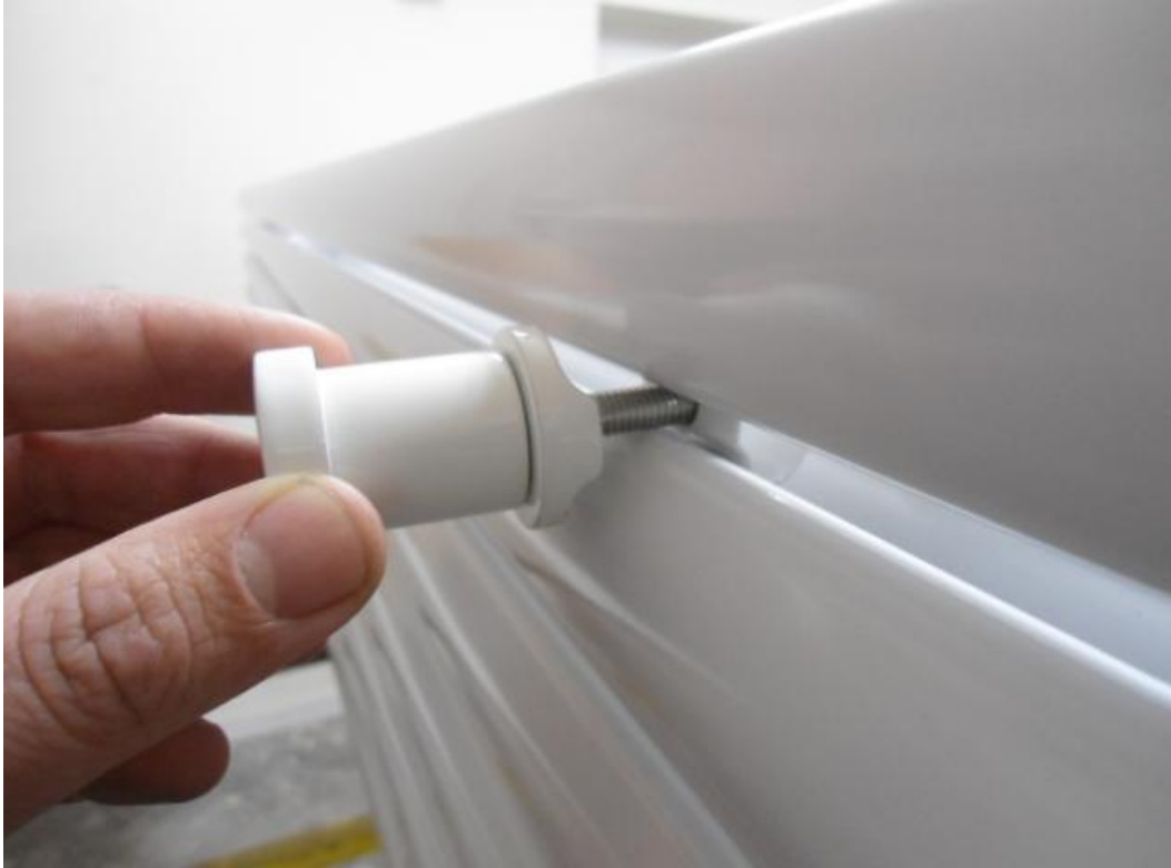
Atornillar la sección posterior del soporte (note las secciones del soporte con curvatura van entre las barras del radiador)
