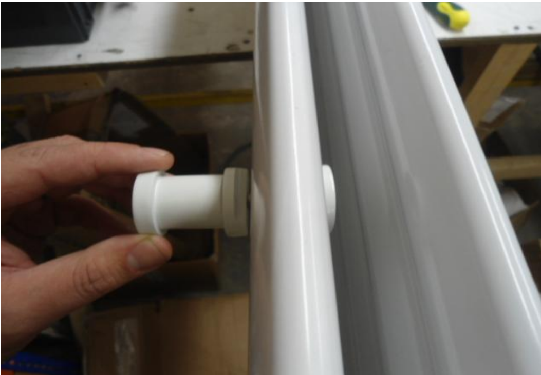
Atornillar la sección posterior del soporte (note las secciones del soporte con curvatura van entre las barras del radiador)
